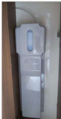
Fig.6.41 - Livello miscela di glicole
