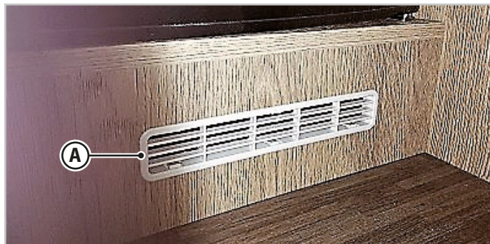
Fig.6.1 - Aperture permanenti di ventilazione
