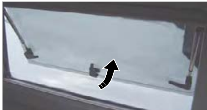
Fig.6.3 - Åpning av vinduer
